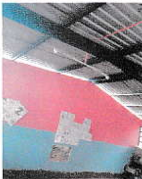
Foto 5: Pintura de muros y paredes
